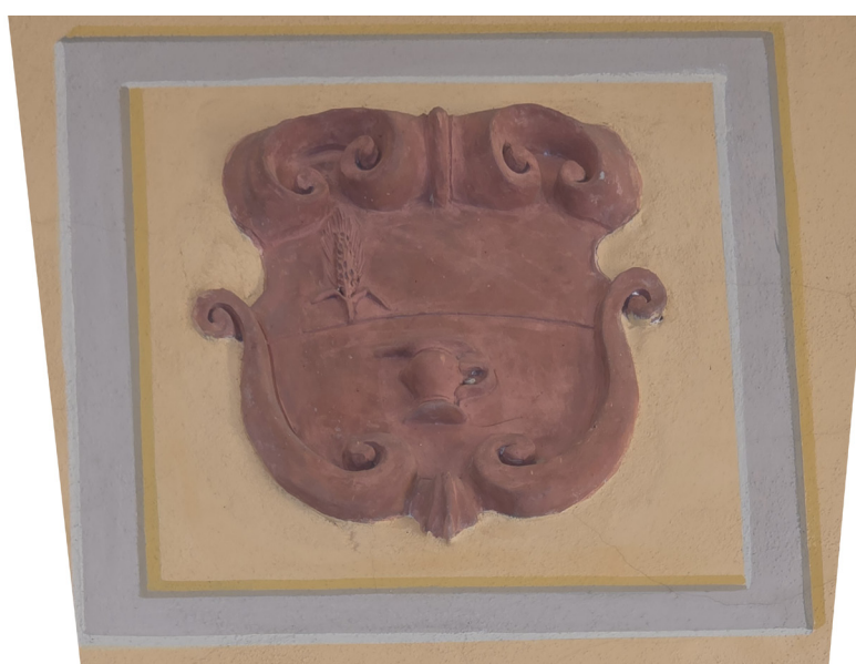
FORMELLA IN COTTO SULLA FACCIATA DEL MUNICIPIO
